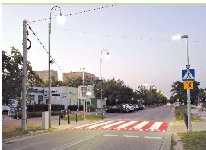
Aktywne przejścia to zsynchronizowany system pulsujących światel poziomych
