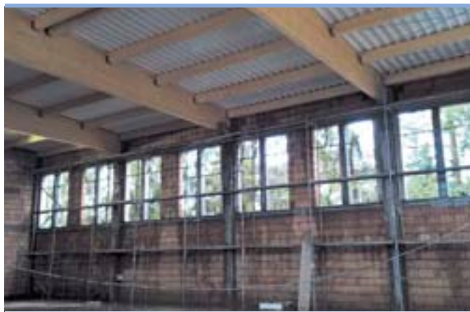
W budynku hali przy „małej trójce” w Wołominie trwają już prace pod dachem
