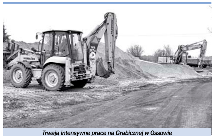
Trwają intensywne prace na Grabicznej w Ossowie
