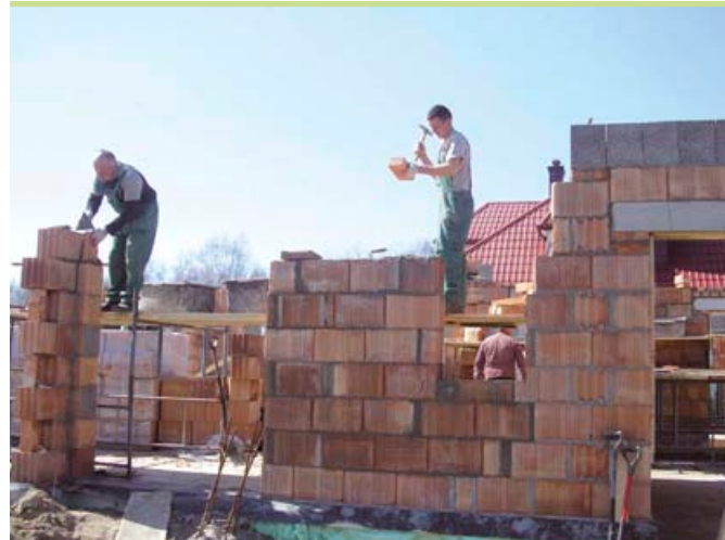
Proces budowy ścian zależy od rodzaju używanych materiałów
