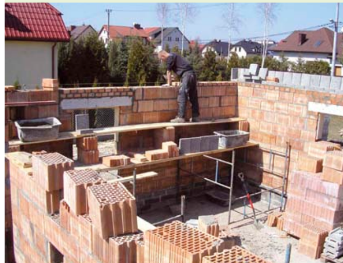
Ważne jest również odpowiednie wykonanie nadproży
