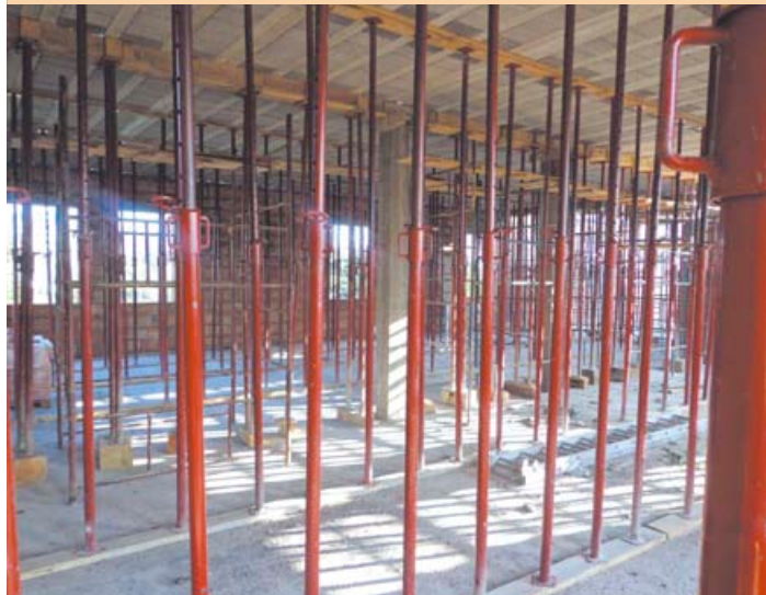
Podpory mocujemy do podciągu co 60 cm pod każdą belką.
