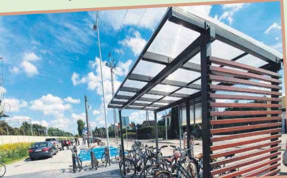
Już wkrótce mieszkańcy gminy Wołomin będą mogli korzystać z nowoczesnego i potrzebnego parkingu P+R przy ul. Przytorowej w Duczkach.
