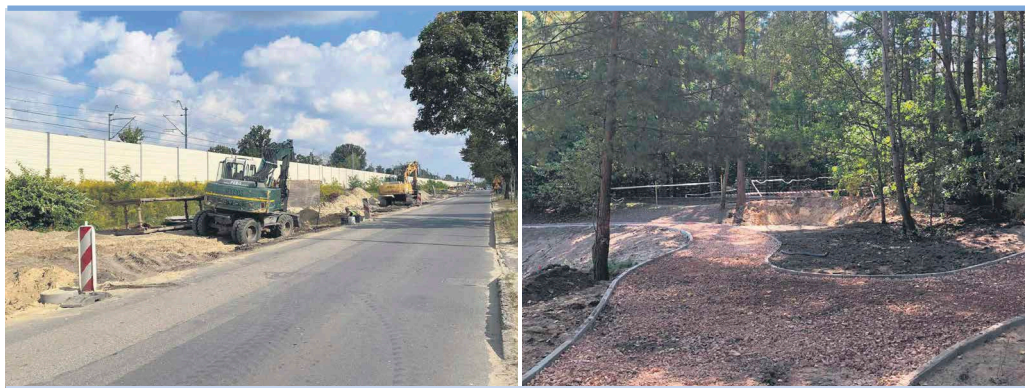
Fot. z lewej: Trwa budowa parkingu przy ul. Jedź w Kobyłce; fot. z prawej rozpoczęła się odbudowa... starego basenu
