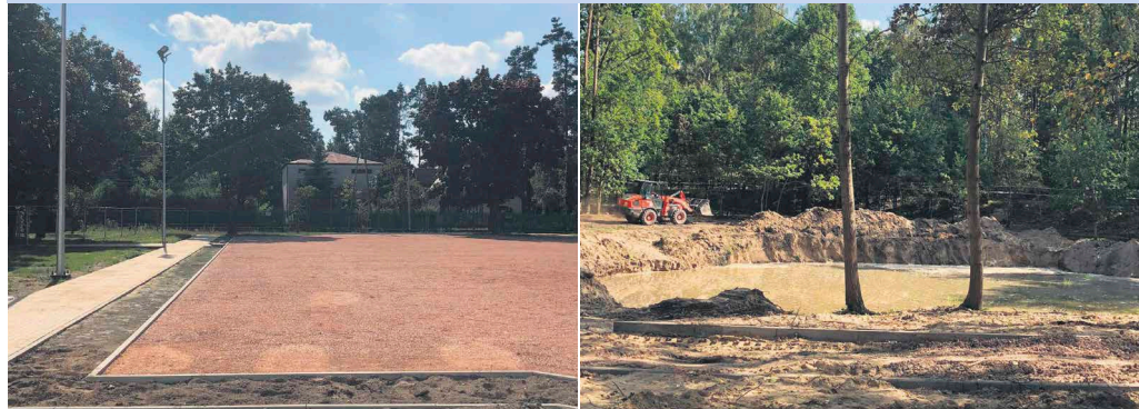
Fot. z lewej: Trwają prace na terenie boiska przy SP nr 2; fot. z prawej: prace na terenie starego basenu
