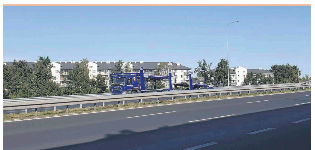
Już niebawem przy obwodnicy Marek powstaną nowe ekrany akustyczne.
