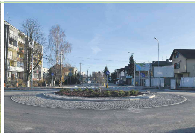
Trwa rozbudowa al. Armii Krajowej w Wołominie
