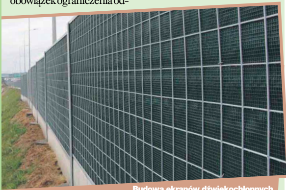
Budowa ekranów dźwiękochłonnych w Zielonce jest II etapem zabezpieczenia akustycznego trasy S8.
