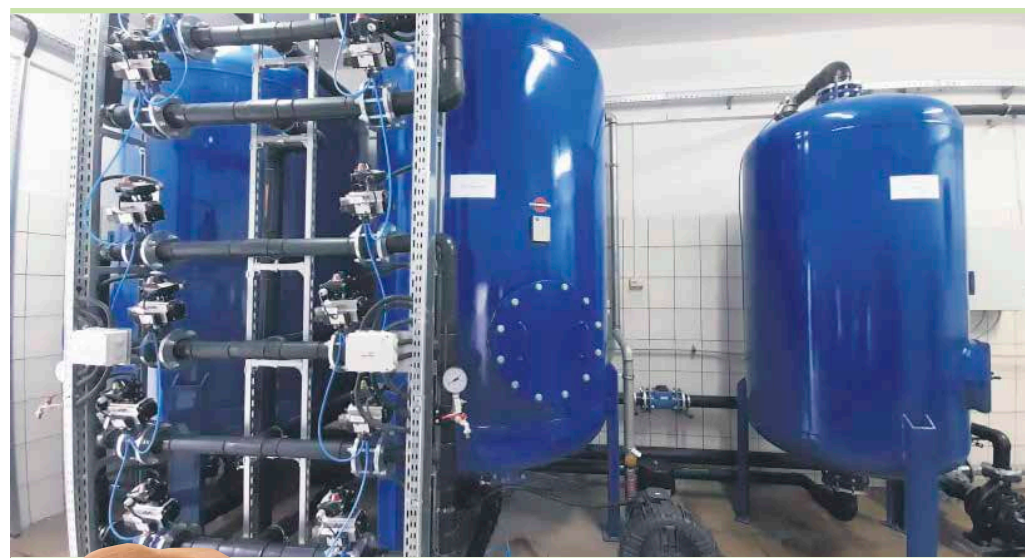
Zakres prac obejmował roboty montażowe, w tym montaż filtrów ciśnieniowych.
