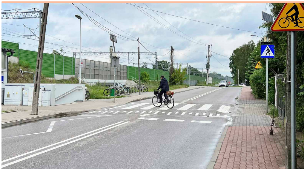
Nowy ciąg pieszo-rowerowy budowany jest w ulicy Słowackiego
