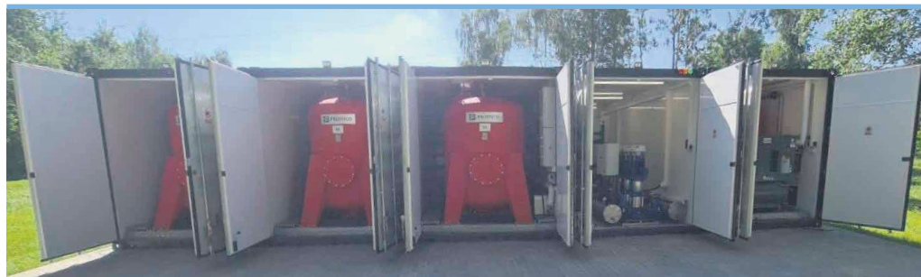
W Kobyłce wybudowano kontenerową stację uzdatniania wody
