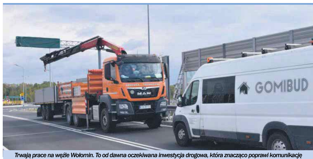
Trwają prace na węźle Wołomin. To od dawna oczekiwana inwestycja drogowa, która znacząco poprawi komunikację
