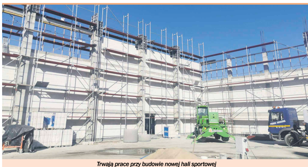
Trwają prace przy budowie nowej hali sportowej
