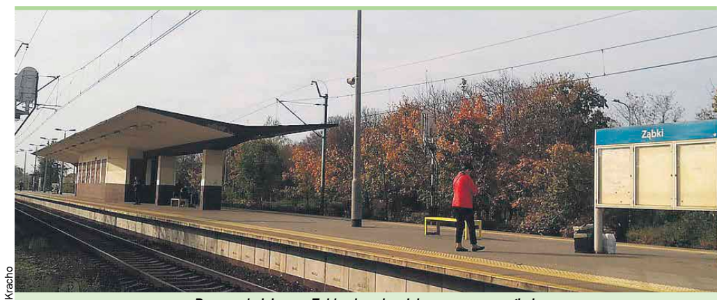
Dworzec kolejowy w Ząbkach zyska niebawem nowy wygląd.
