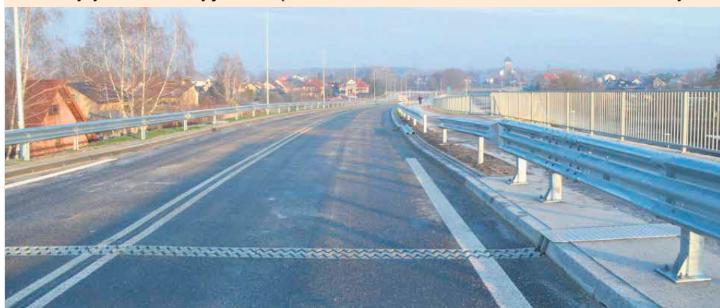
Długość wiaduktu wraz z drogami dojazdowymi to ponad 1 km, w tym prawie 200 metrów przeprawy nad linią kolejową.
