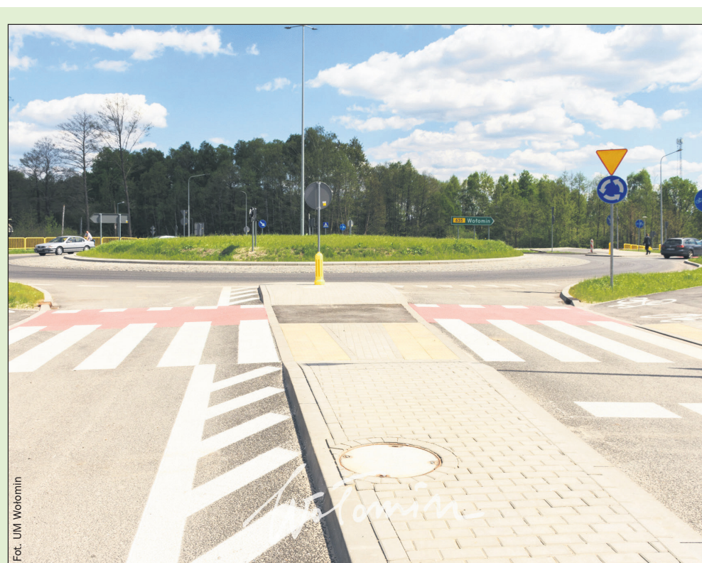
Budowa łącznika z trasą S8 to jedna z inwestycji dofinansowanych z programu „Mazowsze dla równomiernego rozwoju”. Tylko w tym roku sejmik Mazowsza przeznaczył na ten program aż 24,8 mln zł. Dofinansowanie otrzymało 13 inwestycji. Wśród nich znalazły się m.in.: modernizacja Miejskiego Domu Kultury w Wołominie, budowa nowego budynku Gminnej Biblioteki Publicznej w Klembowie czy remont strażnicy w Myszadłach.
