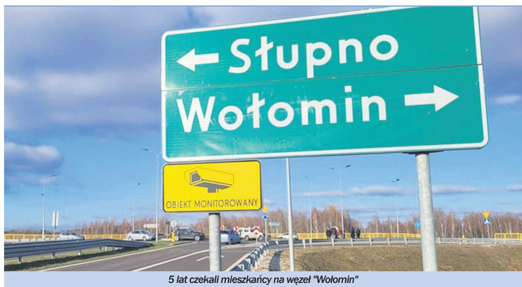
5 lat czekali mieszkańcy na węzeł "Wołomin"
