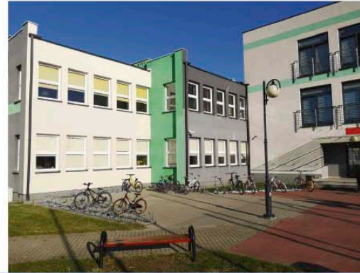
Elewacja PSP nr 3
