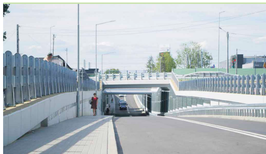
Czy podobny, bezpieczny, przejazd kolejowy już wkrótce zastąpi w Zagościńcu ten niebezpieczny?
