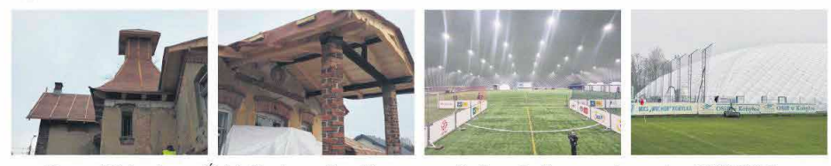
Remont Pałacyku na Źródniku (w realizacji)
