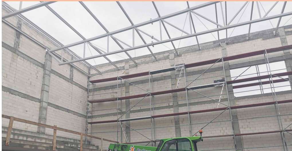
Trwa układanie pokrycia dachowego w hali sportowej przy Szkole Podstawowej nr 2 w Ząbkach
