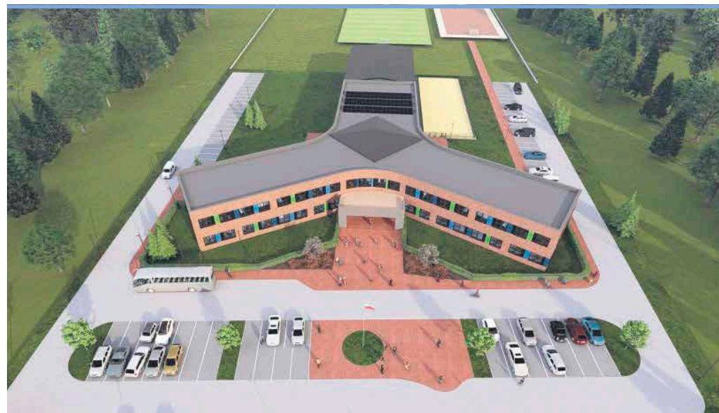
Budowa szkoły w Woli Rasztowskiej to największa inwestycja w gminie Klembów w ostatnim czasie
