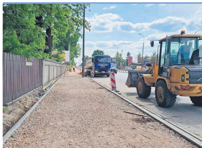
Modernizacja północnego fragmentu Al. Marszałka J. Piłsudskiego w Markach
