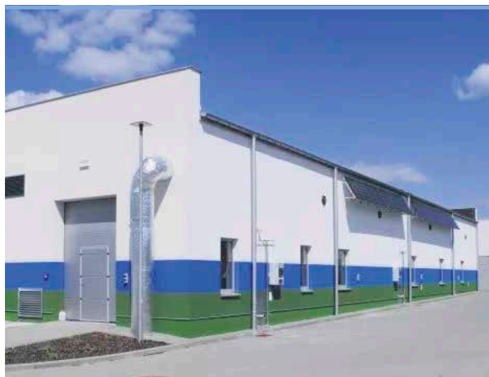
Nowa zlewnia jest w pełni hermetycznym obiektem
