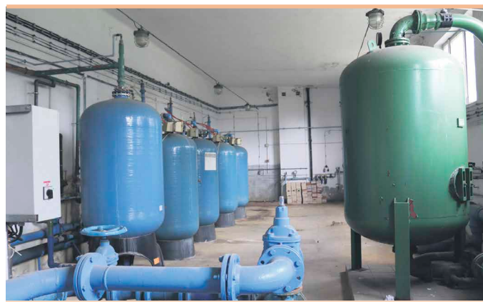
Inwestycja poprawi wydajność i niezawodność systemu zaopatrzenia w wodę.
