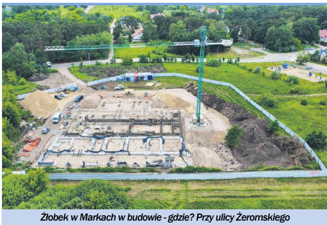
Żłobek w Markach w budowie - gdzie? Przy ulicy Żeromskiego
