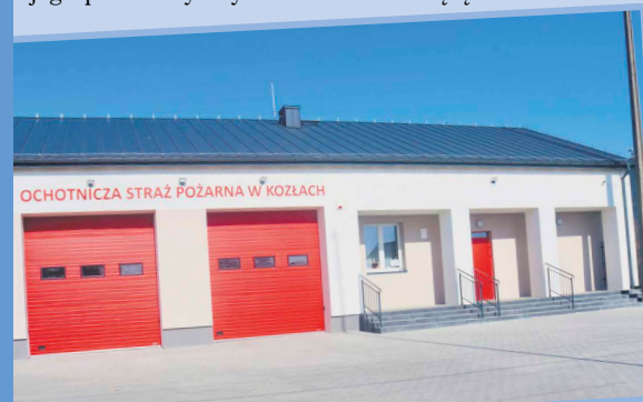
Na bieżący rok zaplanowano kolejny etap prac, tym razem obejmujący świetlicę mieszczącą się w strażnicy.
